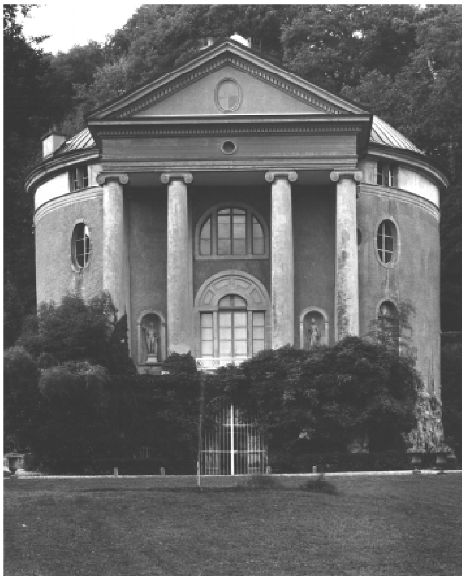
Villa La Gordanne: célèbre demeure, notamment pour son plan circulaire, caractérisée par un portique à colonnes ioniques et couverte d'un dôme. La Gordanne élève sa remarquable silhouette inspirée du Panthéon parmi les frondaisons d'un parc admirablement arborisé. Implantée au confluent des ruisseaux de la Gordanne et de l'Eau noire, la maison de maître est située sur la commune de Féchy, le reste de la propriété se trouvant par ailleurs à cheval sur les territoires d'Allaman et de Perroy.
