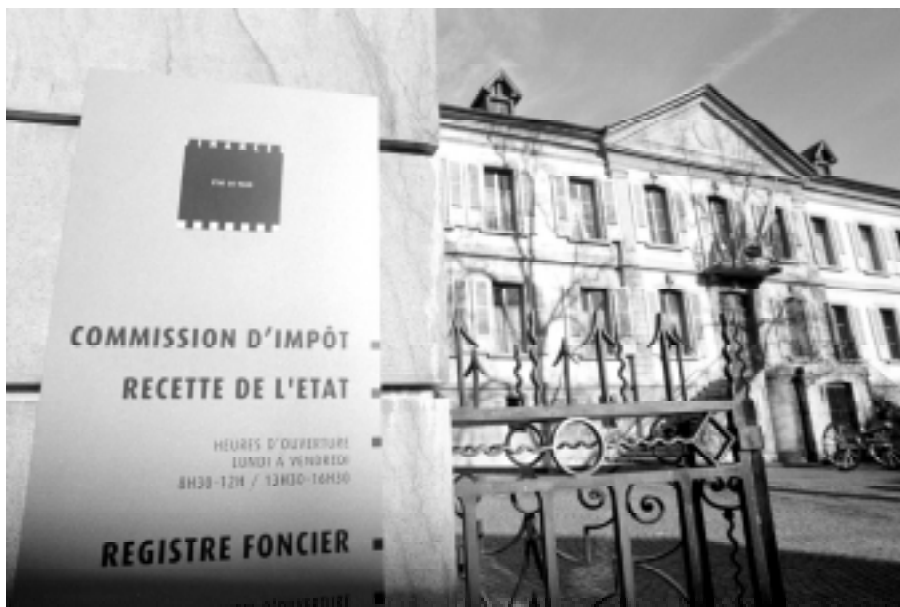
A Vevey, le bâtiment des services de l'Etat regroupe la Commission d'impôt, la Recette de l'Etat, le Registre foncier et la Préfecture.
