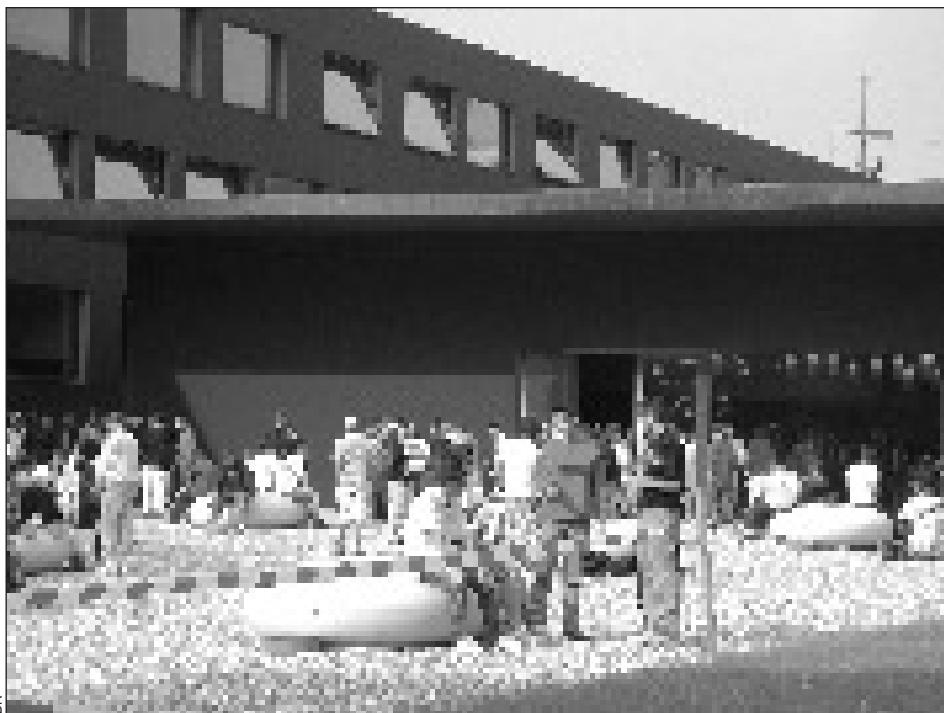
26 août 2002, les premiers apprentis arrivent à Marcelin. La couleur très sombre du bâtiment s'harmonise avec les ombres du paysage et réduit l'impact visuel du volume.
