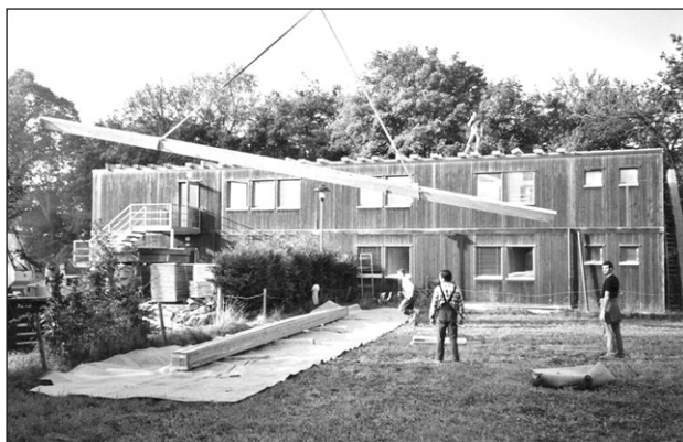
Déconstruction du centre de la FAREAS de la Grangette à Lausanne.
