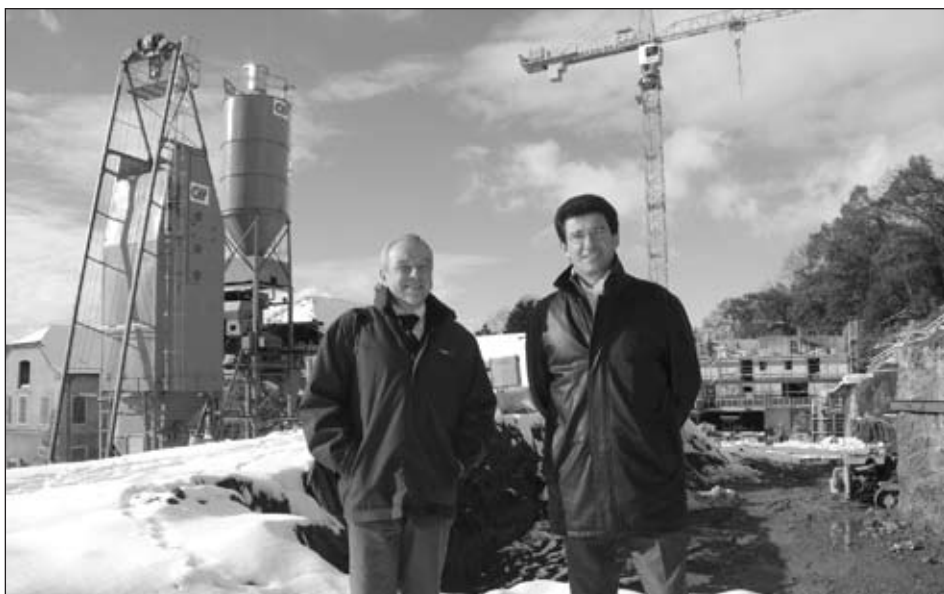
Jean-Pierre Pilet, chef de la section des opérations immobilières et Philippe Pont, chef du Service immobilier et logistique et futur chef du SIPAL (voir p.7) devant le chantier du futur Domaine résidentiel de la Bourdonnette.
