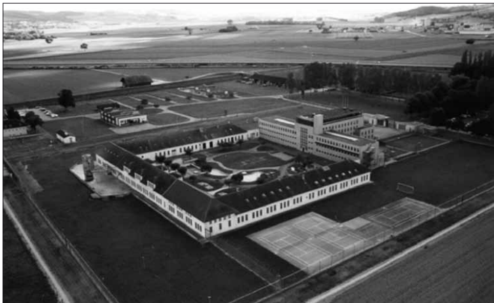
La division d'attente des EPO sera reconstruite et aménagée cet été.
