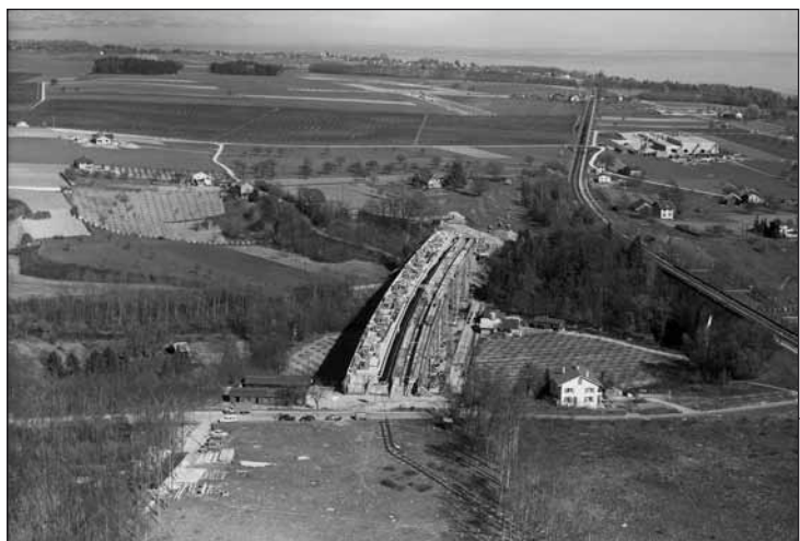
Construction du viaduc de l'A1 sur l'Aubonne en 1960.
